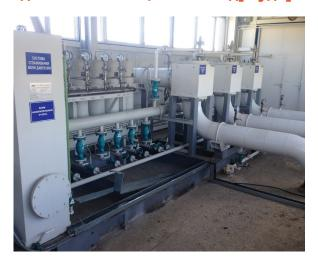
стороны, давление управляющей системы. Конструкция запорного элемента клапана выполнена таким образом, что при стационарном режиме перекачки клапан надежно закрыт. При увеличении давления нефти баланс сил на поршне клапана нарушается и клапан переходит в режим открытия и поддержания заданного управляющей системой давления. При этом происходит контролируемый сброс нефти в станционные резервуары.
