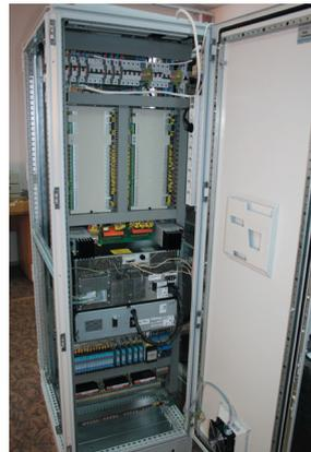
Моноблочный вариант ИВК, устройство(а) сопряжения с объектом и блок обработки информации располагаются конструктивно в одном корпусе.
